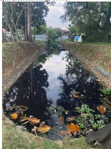
Gambar 8: Endapan lumpur di dasar sungai akibat limbah batik mengurangi kapasitas sungai dan memperburuk kondisi lingkungan.
