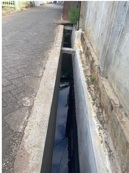
Gambar 3: Proses pembuangan limbah cair dari pabrik batik ke sungai di Pekalongan Utara.
