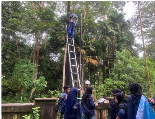
Gambar 6. Pemasangan Lampu PJU *Solar Cell*
